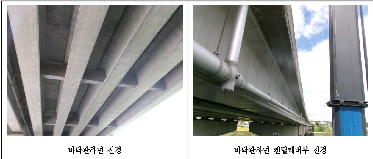
【사진 36.3.2】 바닥판하면 전경
