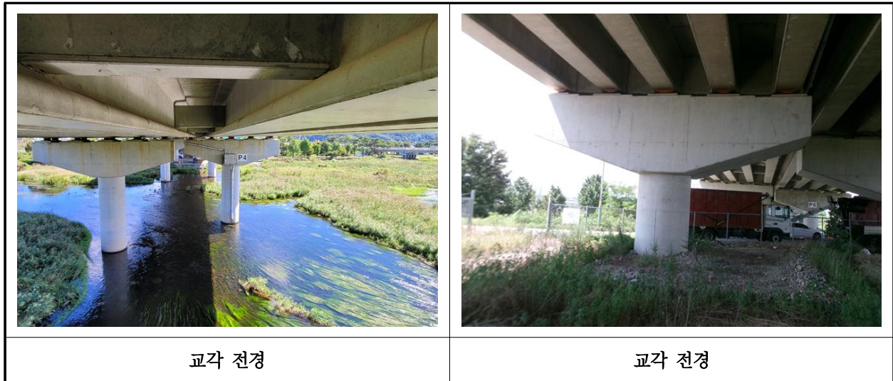
【사진 36.3.37】 교각 전경
