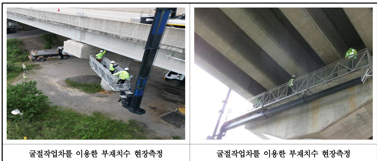
【사진 36.2.1】 부재 현장측정 전경
