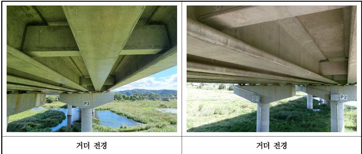
【사진 36.3.31】 거더 전경
