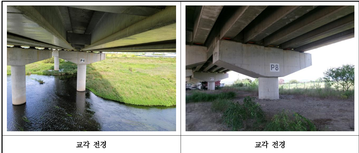
【사진 36.3.10】 교각 전경
