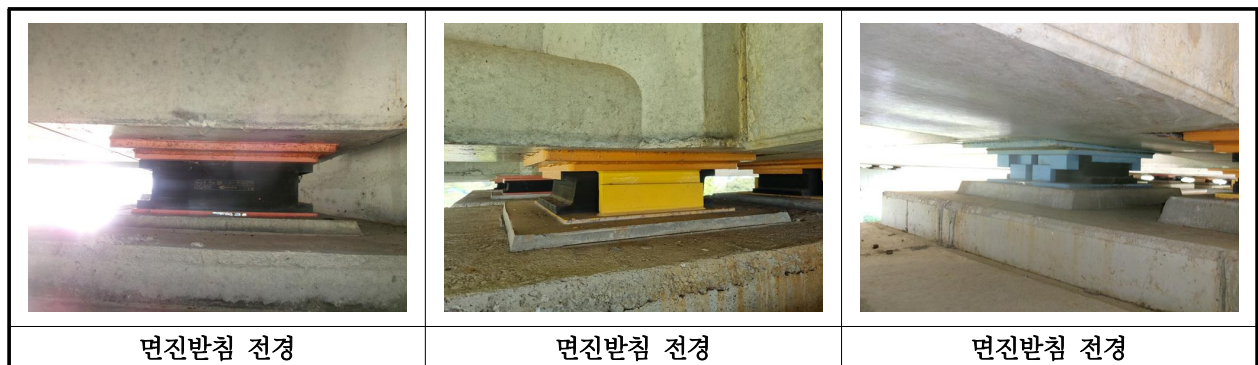
【사진 36.3.40】 교량받침 전경
