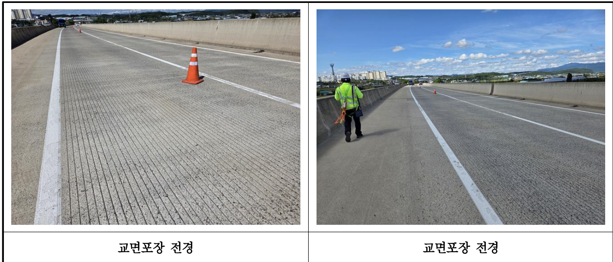
【사진 36.3.47】 교면포장 전경
