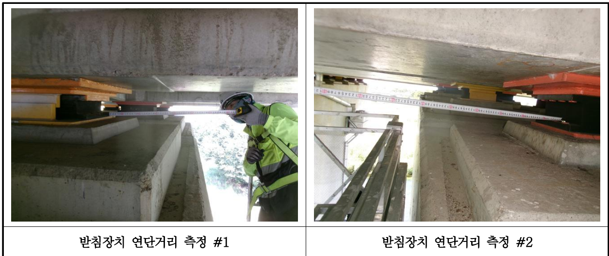
【사진 36.3.15】 교량받침장치 연단거리측정
