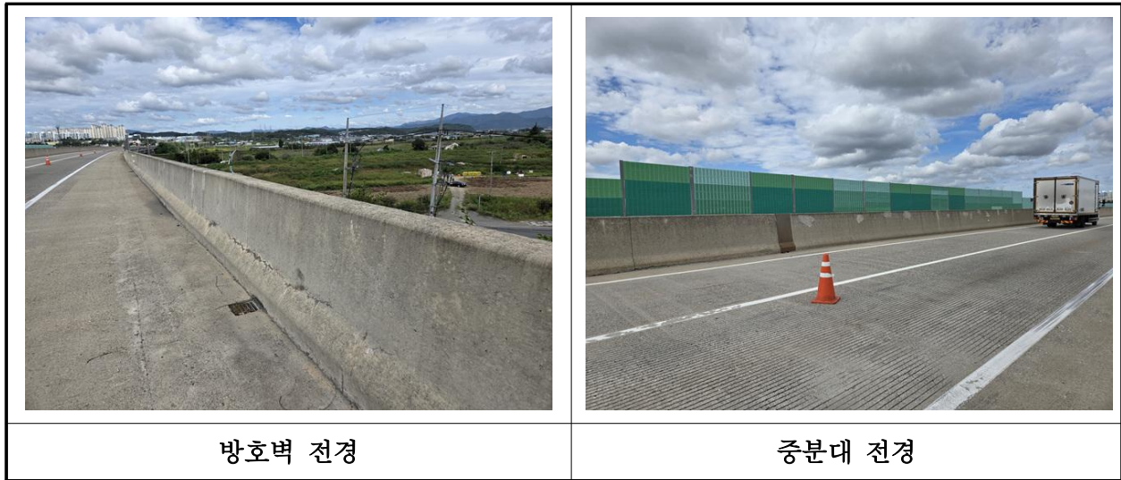
【사진 36.3.24】 방호벽 및 중분대 전경
