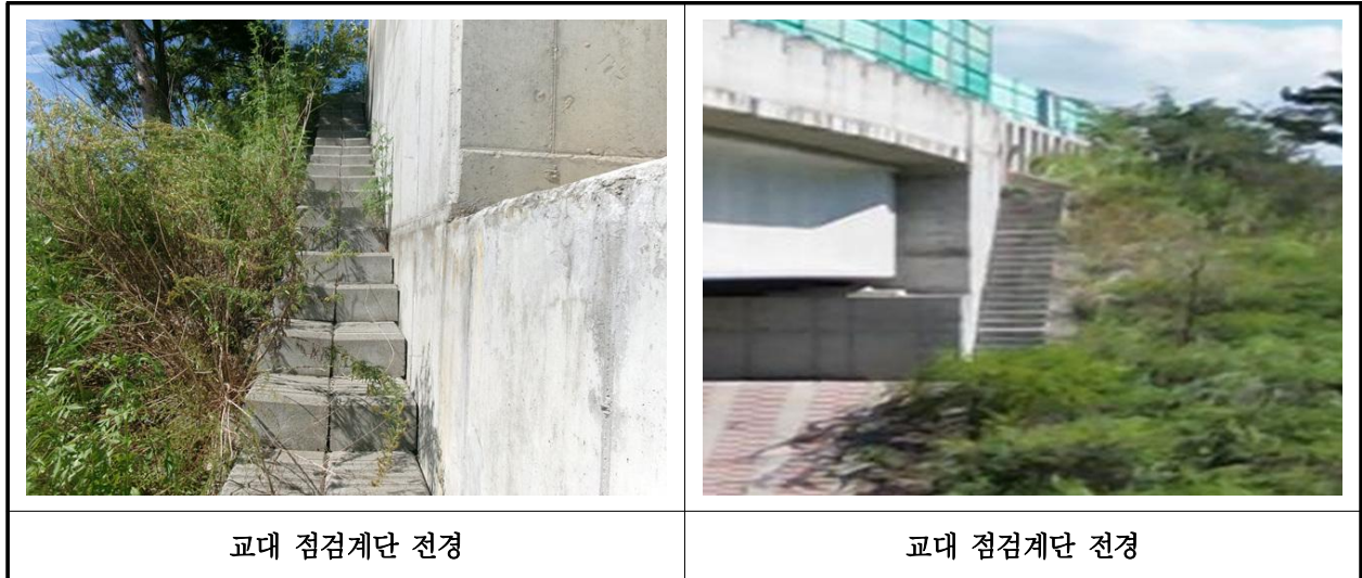
【사진 36.3.54】 교량 점검시설 전경
