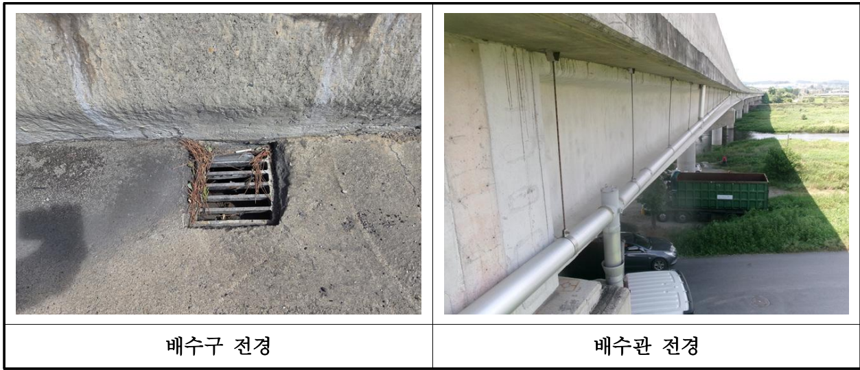
【사진 36.3.22】 배수시설 전경
