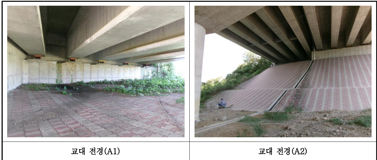
【사진 36.3.8】 교대 전경
