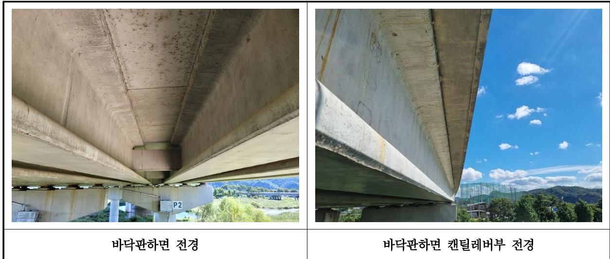
【사진 36.3.29】 바닥판하면 전경
