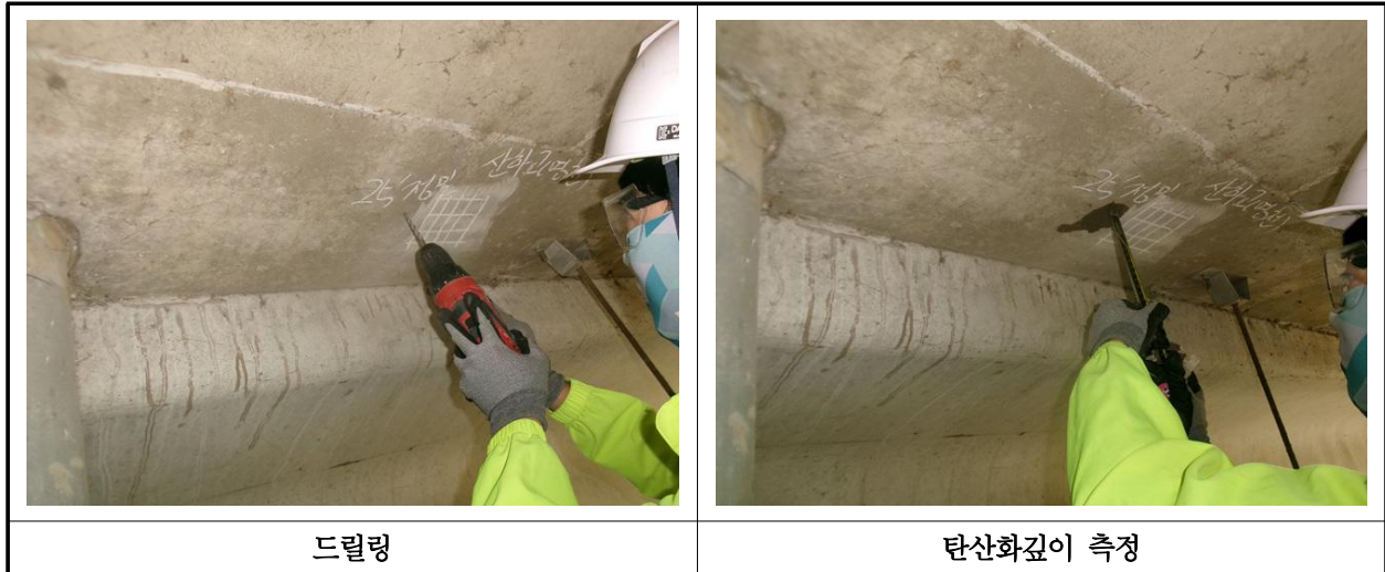
【사진 36.4.3】 탄산화 깊이 측정 현장사진
