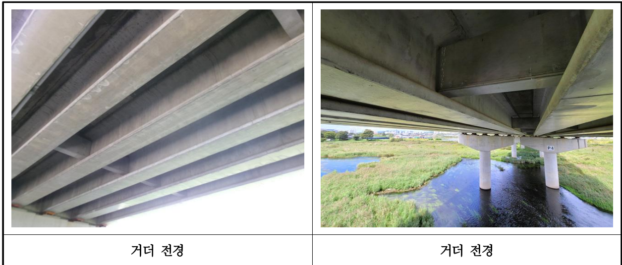
【사진 36.3.4】 거더 전경
