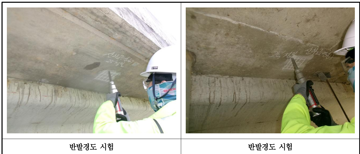
【사진 36.4.2】 반발경도시험 현장사진
