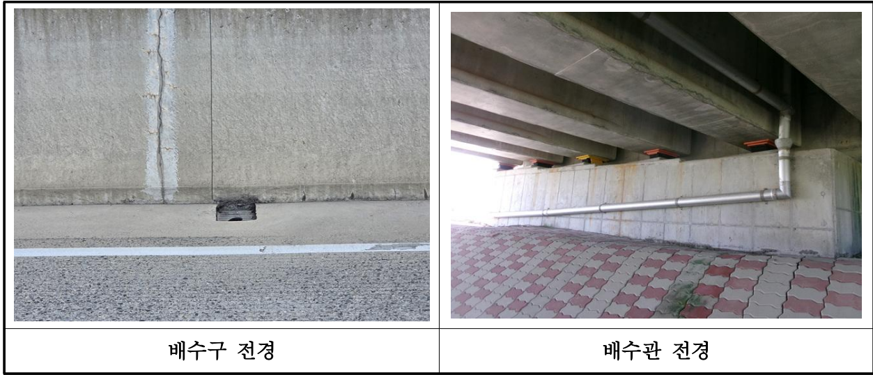
【사진 36.3.50】 배수시설 전경
