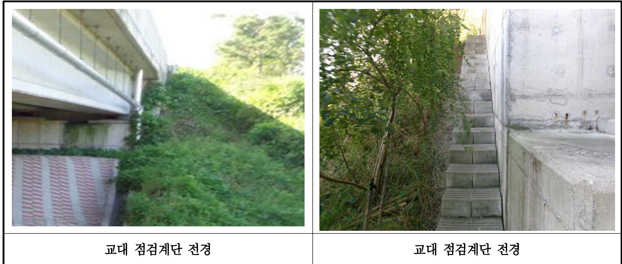
【사진 36.3.26】 교량 점검시설 전경
