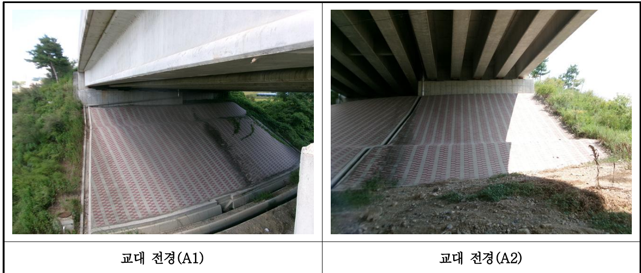
【사진 36.3.35】 교대 전경
