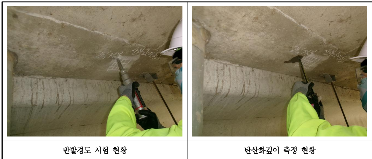
【사진 36.4.1】 콘크리트 내구성조사 현황
