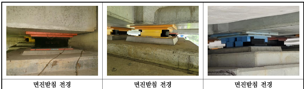
【사진 36.3.13】 교량반침 전경
